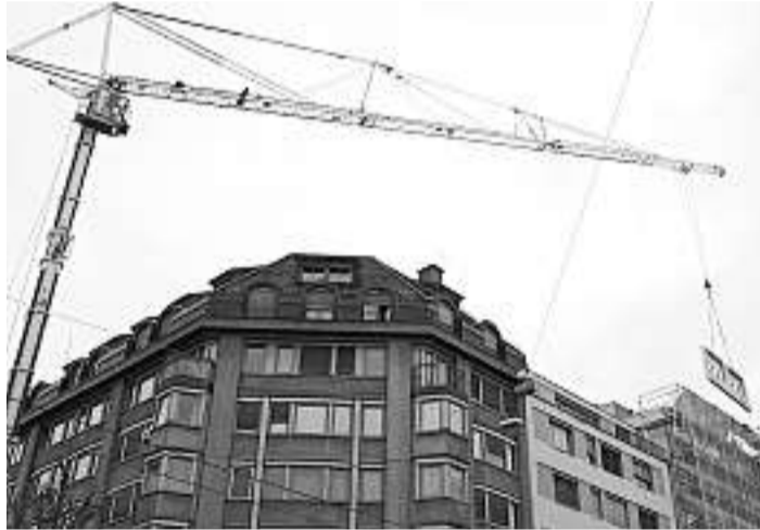
Innovative Fassadensanierung mitten in Luzern.
