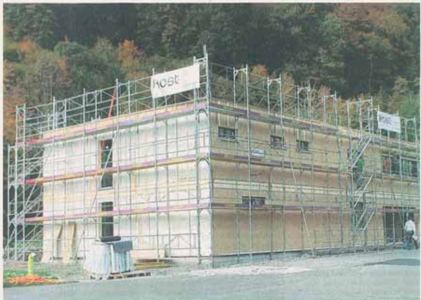
Rohbau erstellt: Das Dienstgebäude für die Übungsanlage für Feuerwehr und Zivilschutz ist unter Dach. Im Frühjahr erfolgt die Inbetriebnahme.
