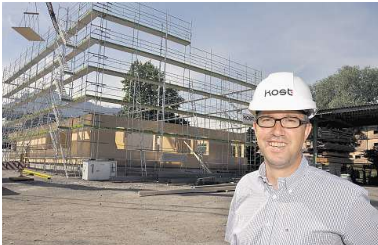
Hier entsteht der Neubau der Kost Holzbau AG: Geschäftsleiter Robert Schmidlin bei der Baustelle im Küssnacher Fänn Ost freut sich über den Baufortschritt.
