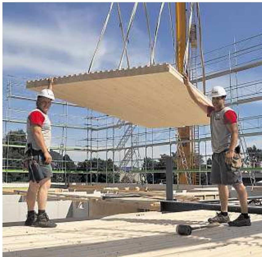
Über dem Erdgeschoss: Die beiden Poliere Karl Hediger (links) und Peter Nussbaumer montieren die Bodenplattenelemente aus Holz.
