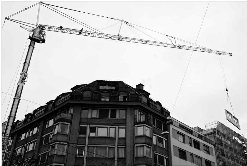
Der neue Mobilbaukran MK 110 der Christen AG transportiert ein vorgefertigtes Fassadenelement der Kost Holzbau AG zum Gebäude an der Hirschmattstrasse 40.
