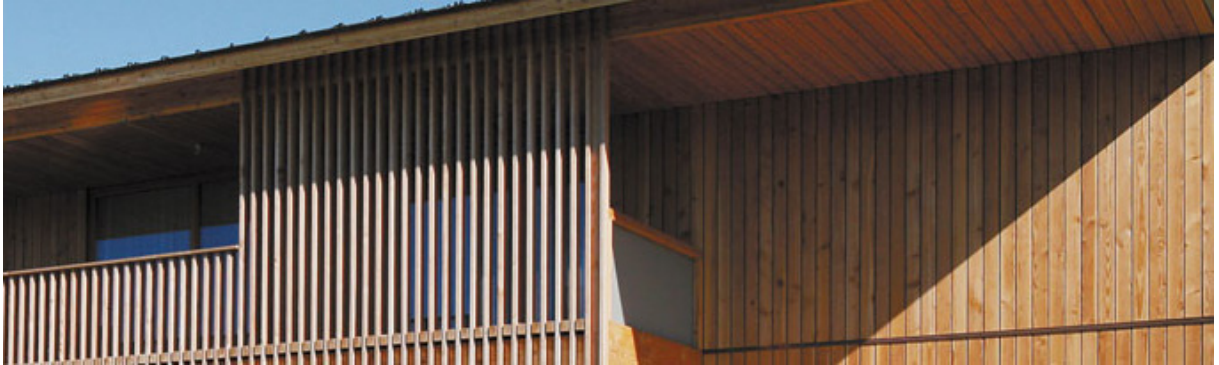
Fassadenausschnitt der vertikalen Holzverkleidung
