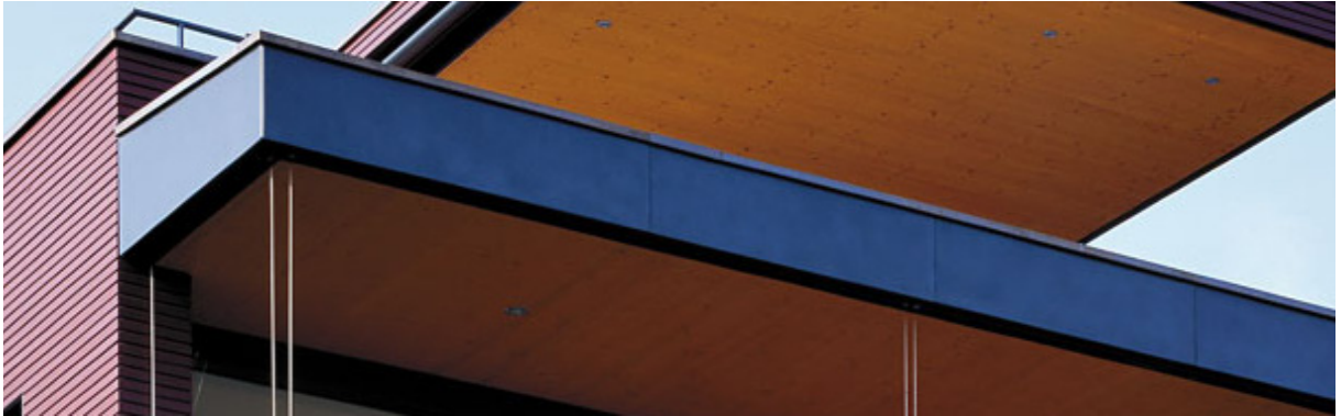
Untersicht auskragendes Vordach
