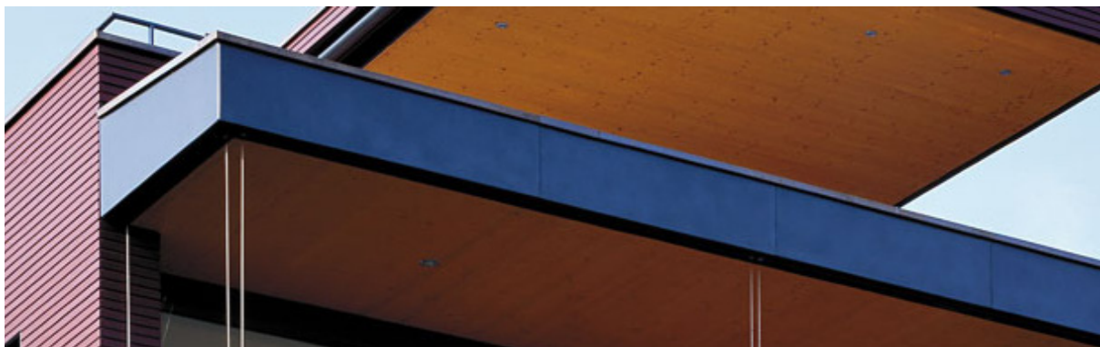
Untersicht auskragendes Vordach
