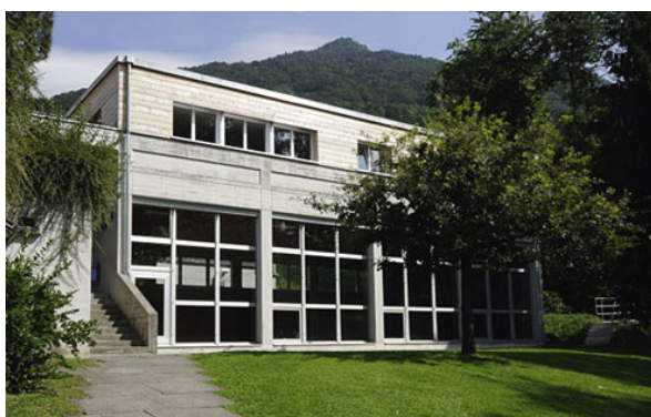
Schultrakt mit Turnhalle
