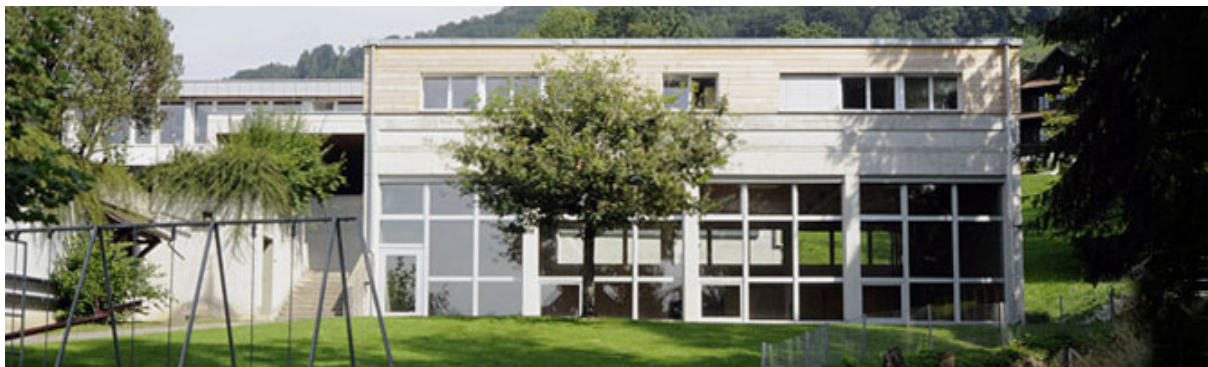
Schultrakt mit Turnhalle
