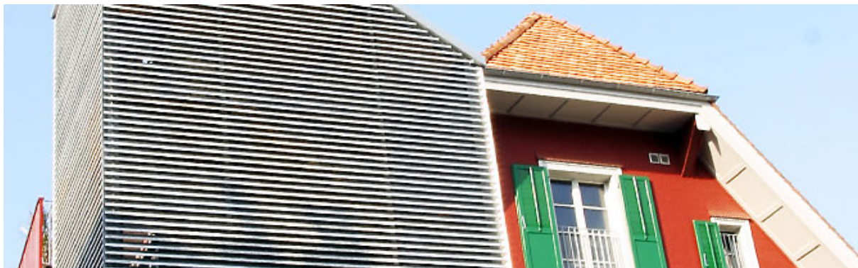
Neuer Anbau Treppenturm
